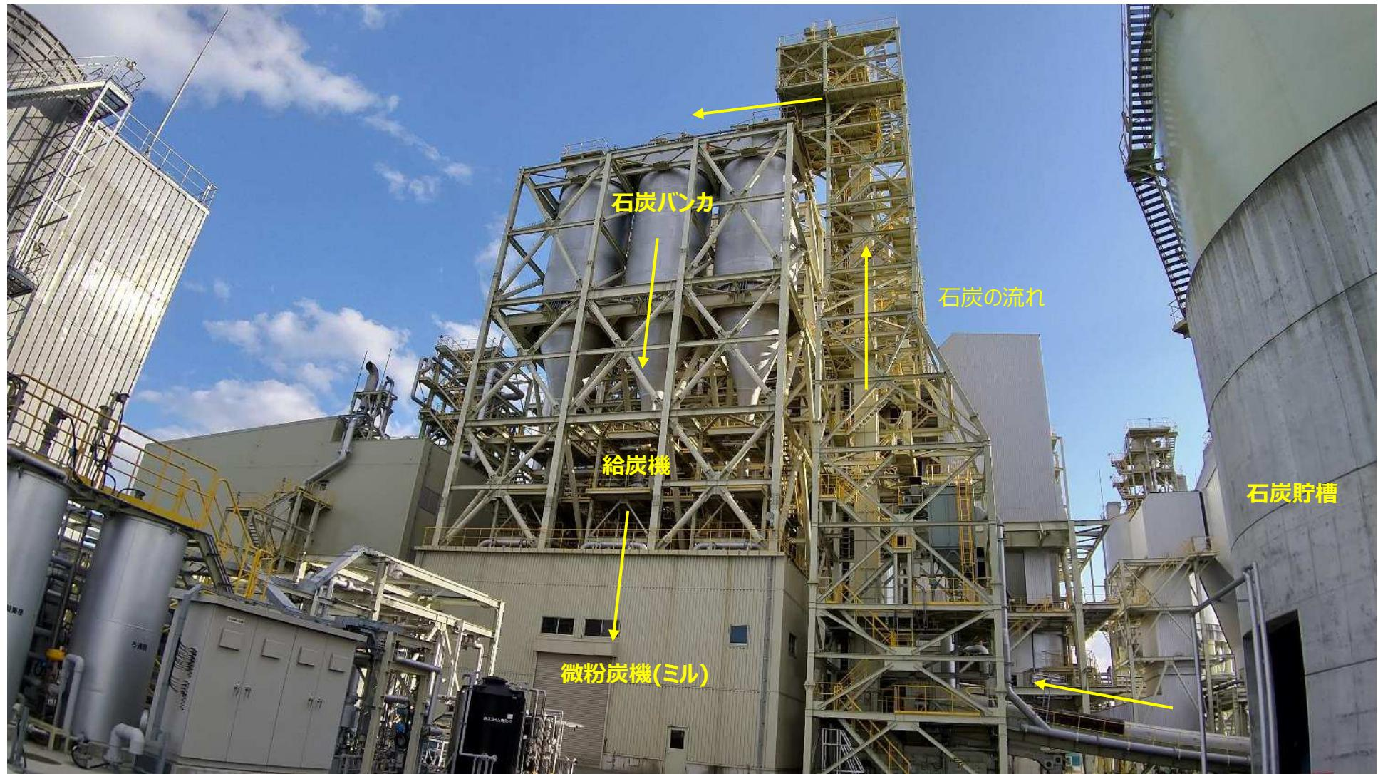
石炭貯槽から払出された石炭は、ボイラで燃焼しやすいうるようにするために、微粉炭機で粉末状にしてボイラに送っています。この微粉炭機に送る前の石炭を一時的に貯めておくのが石炭バンカです。
