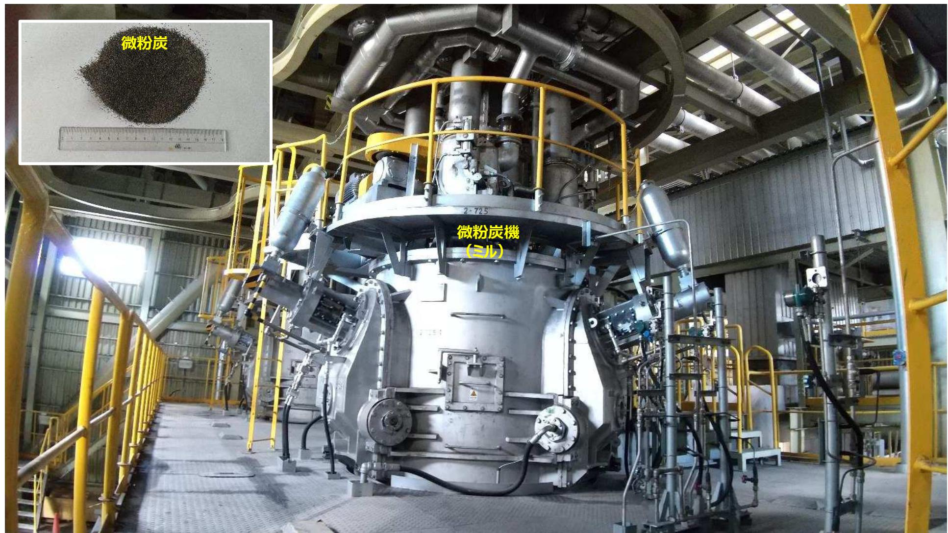
給炭機から送られた石炭は、燃焼しやすいように微粉炭機(ミル)で粉末状にしてボイラに送ります。
