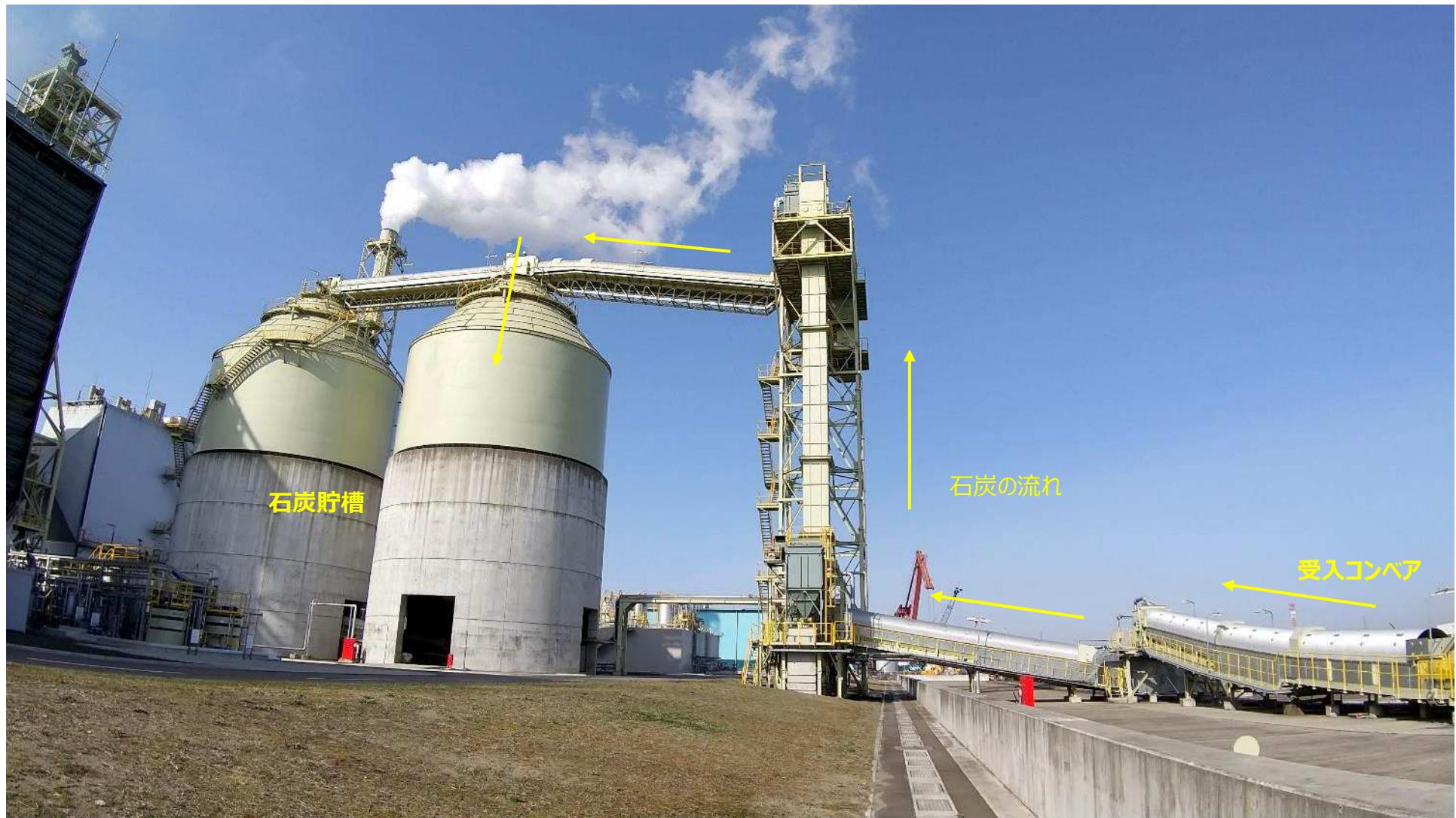
揚炭機で陸揚げされた石炭は、受入コンベアにより石炭貯槽まで運ばれます。石炭の運搬にあたっては、運搬・貯槽設備を密閉構造等にすることで、粉じんの飛散を防止しています。石炭貯槽の容量は $4,000\text{m}^3$ (約3,200t)×2基です。
