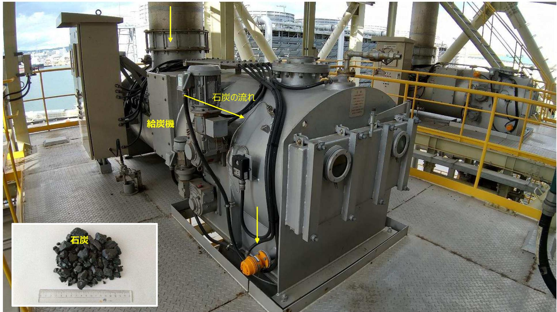
給炭機は、石炭バンカから送られる石炭を連続的に微粉炭機(ミル)に供給する設備であり、ここでボイラへの送炭量を制御しています。
