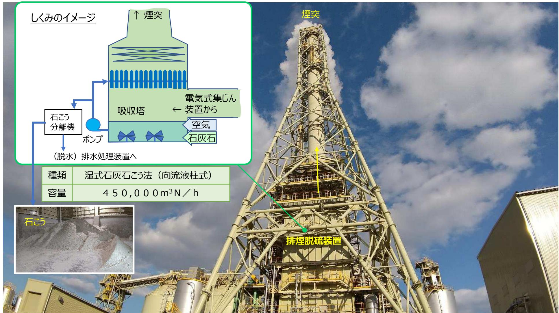
排煙脱硫装置は、排ガスから硫黄酸化物を取り除き、浄化するための装置です。当所では、煙突と排煙脱硫装置が一体型となっています。煙突の高さは80mです。湿式石灰石こう法で副産物として生成した石膏はセメント原料や建材原料(石膏ボード)として、セメント会社等へ全量リサイクルしています。
