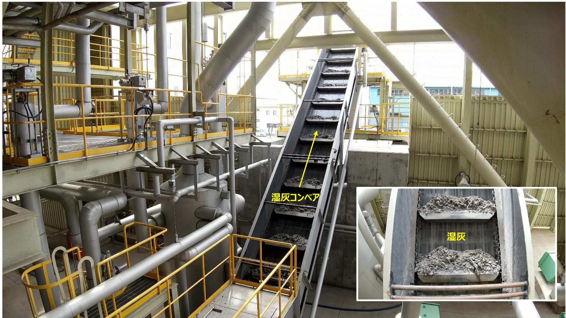
ボイラで石炭燃焼後に発生した石炭灰の内、ボイラ下部の水槽へ落下し、湿った状態で回収される石炭灰(湿灰)は、コンベアで湿灰貯槽に運搬されます。この湿灰は、セメント原料としてセメント会社へ全量リサイクルしています。
