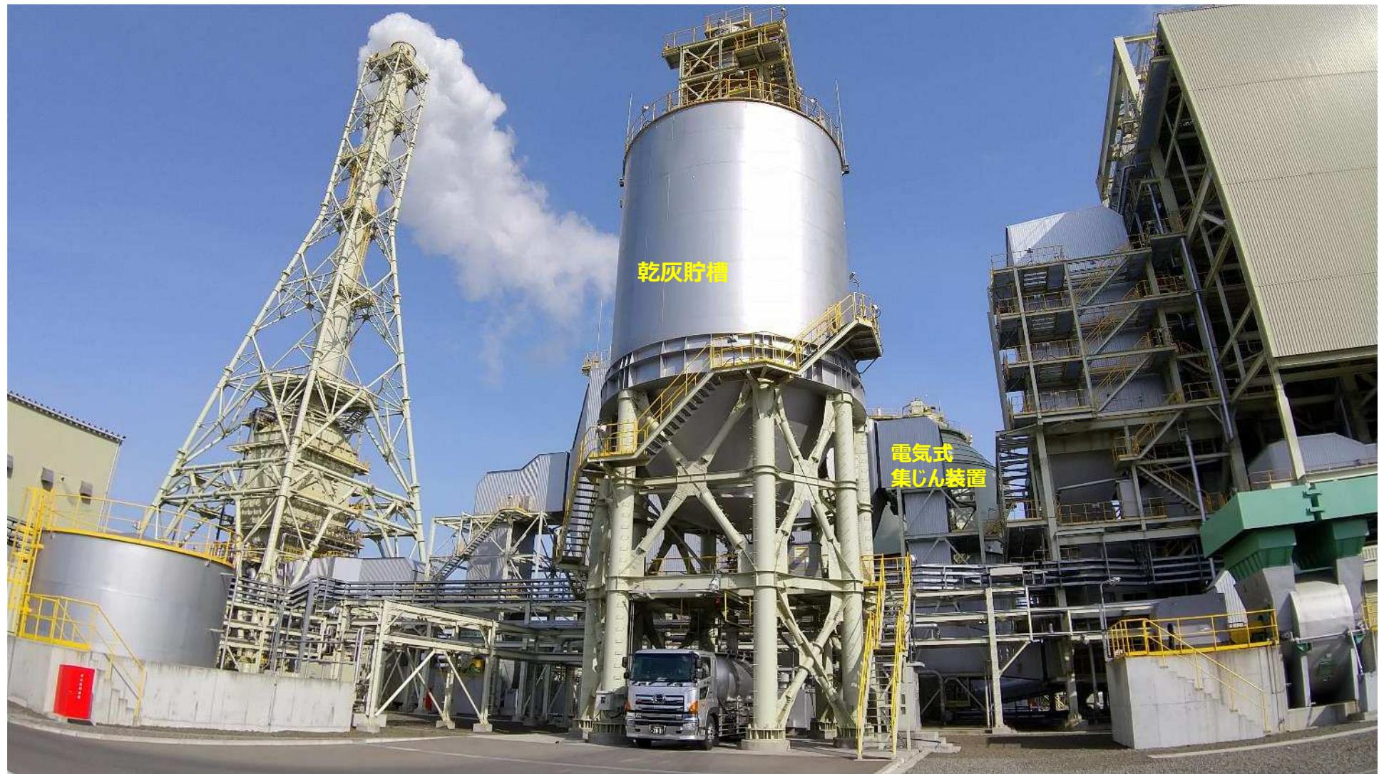
ボイラで石炭燃焼後に発生した石炭灰の内、電気式集じん装置で回収されたばいじんを貯槽する乾灰貯槽です。
