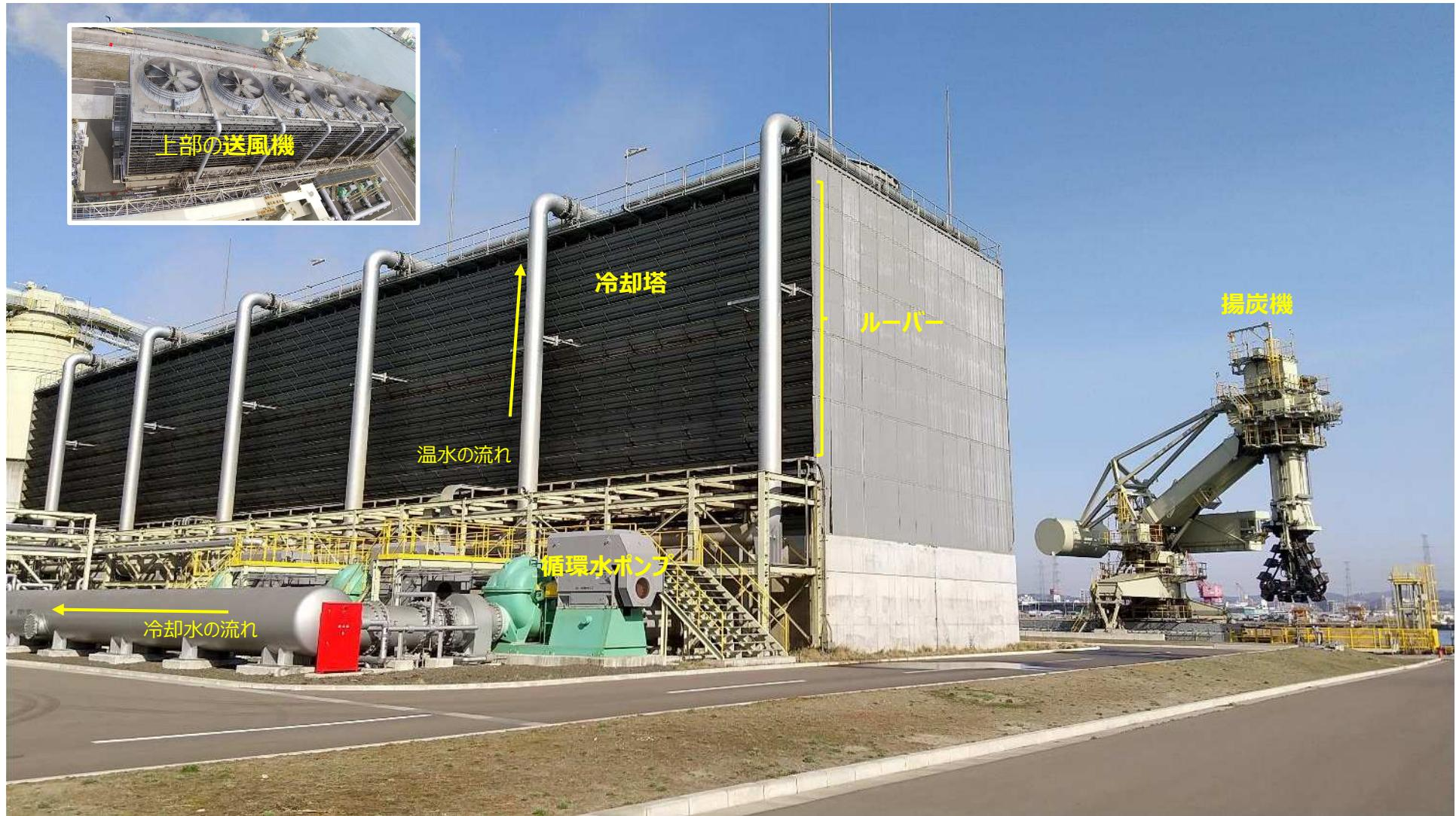
発電所で使う冷却水を確保する冷却塔です。上部の送風機により外気をルーバーから吸い込み、上部から散水された温水と熱交換させて、下部のコンクリート部に貯水しています。冷却された水は、緑色の循環水ポンプで復水器に送られています。右に見えるのは、石炭を陸揚げする揚炭機です。
