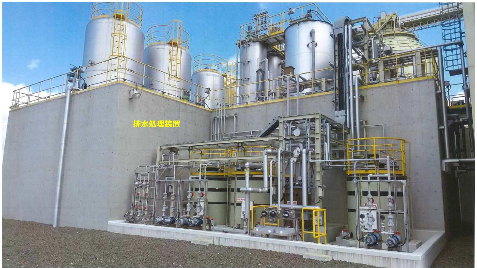
発電所稼働に伴い発生する排水は、この排水処理装置で、凝集沈殿、ろ過、中和等の処理を行い、浄化した上で放流しています。
