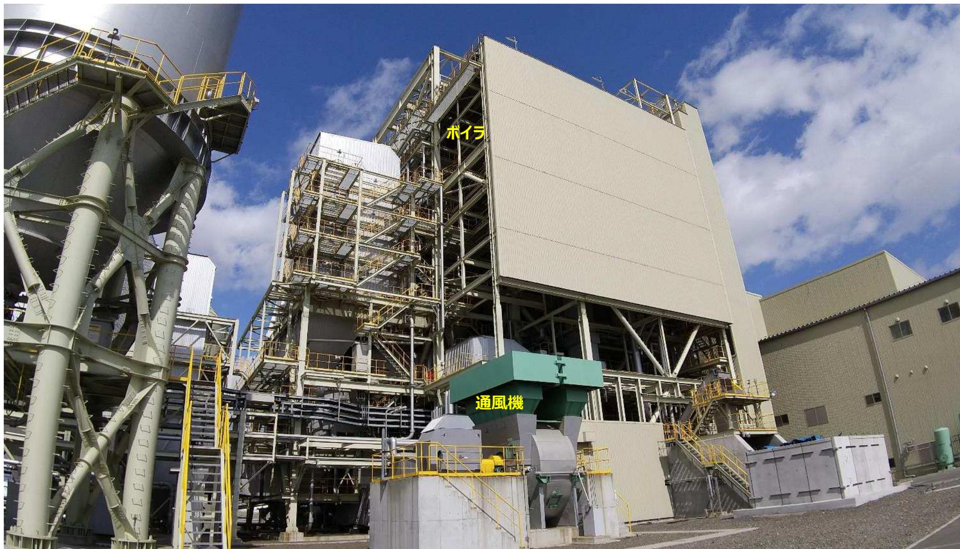
タービン発電機を回すための高温高圧の蒸気をつくるボイラです。最大蒸発量は355t/hです。
