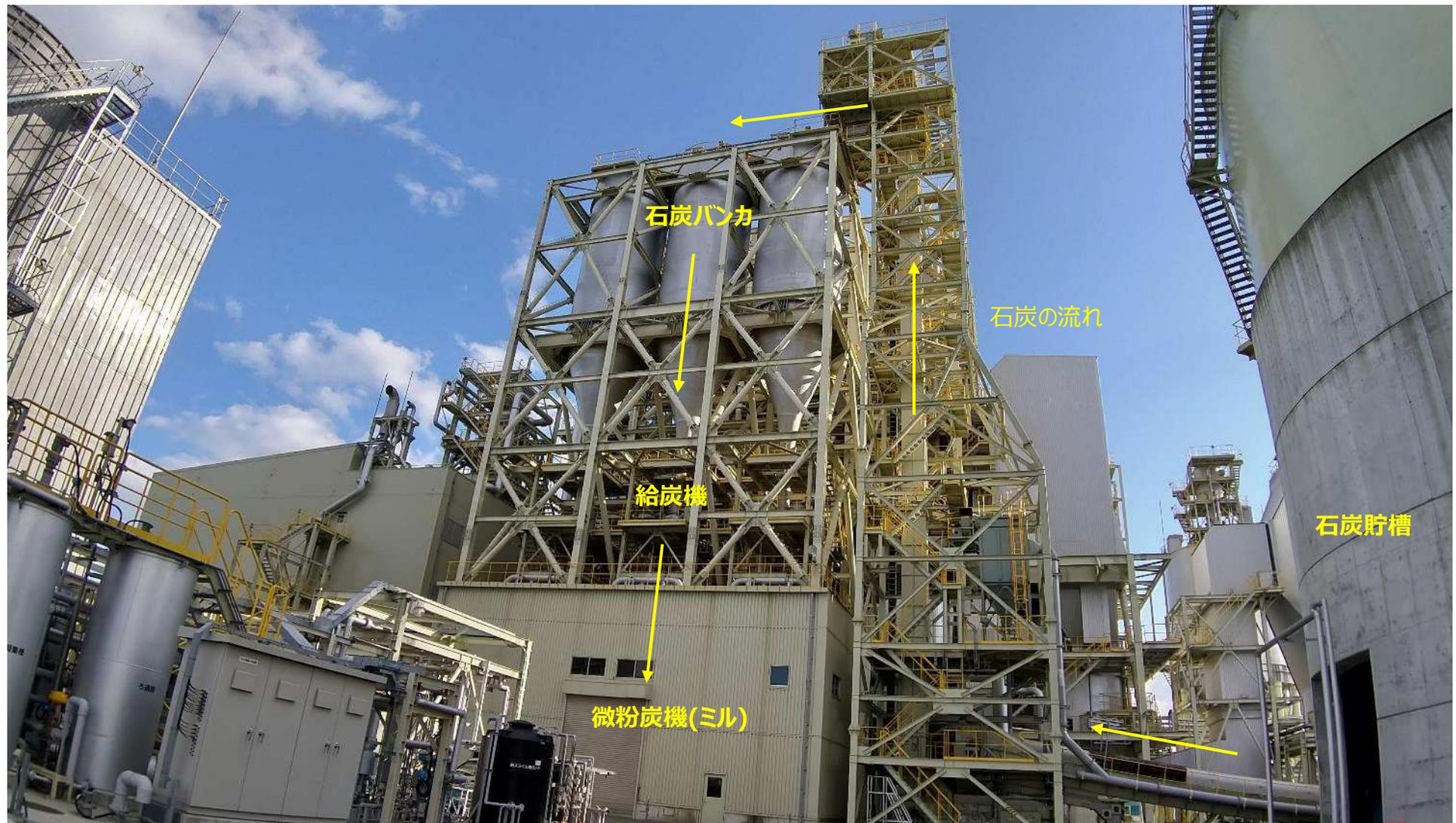
石炭貯槽から払出された石炭は、ボイラで燃焼しやすいようにするために、微粉炭機で粉末状にしてボイラに送っています。この微粉炭機に送る前の石炭を一時的に貯めておくのが石炭バンカです。
