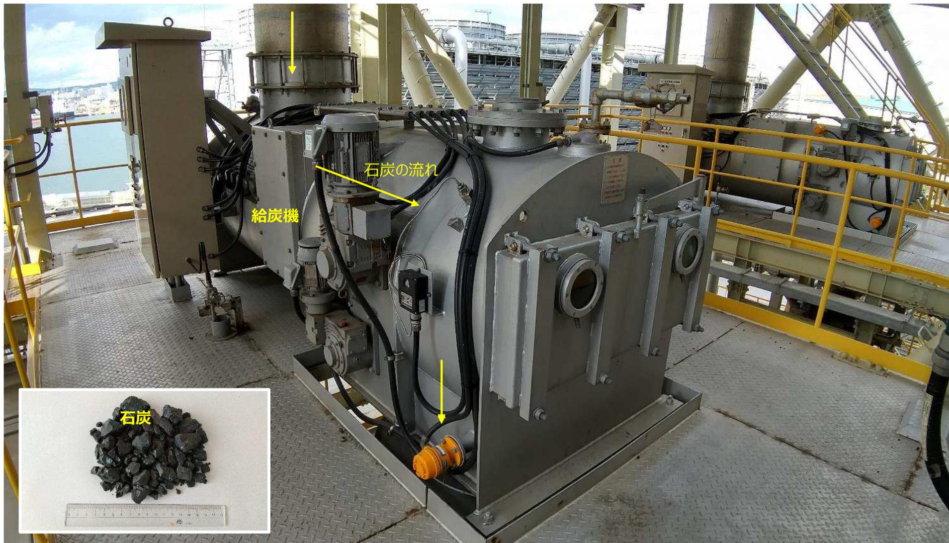
給炭機は、石炭バンカから送られる石炭を連続的に微粉炭機(ミル)に供給する設備であり、ここでボイラへの送炭量を制御しています。
