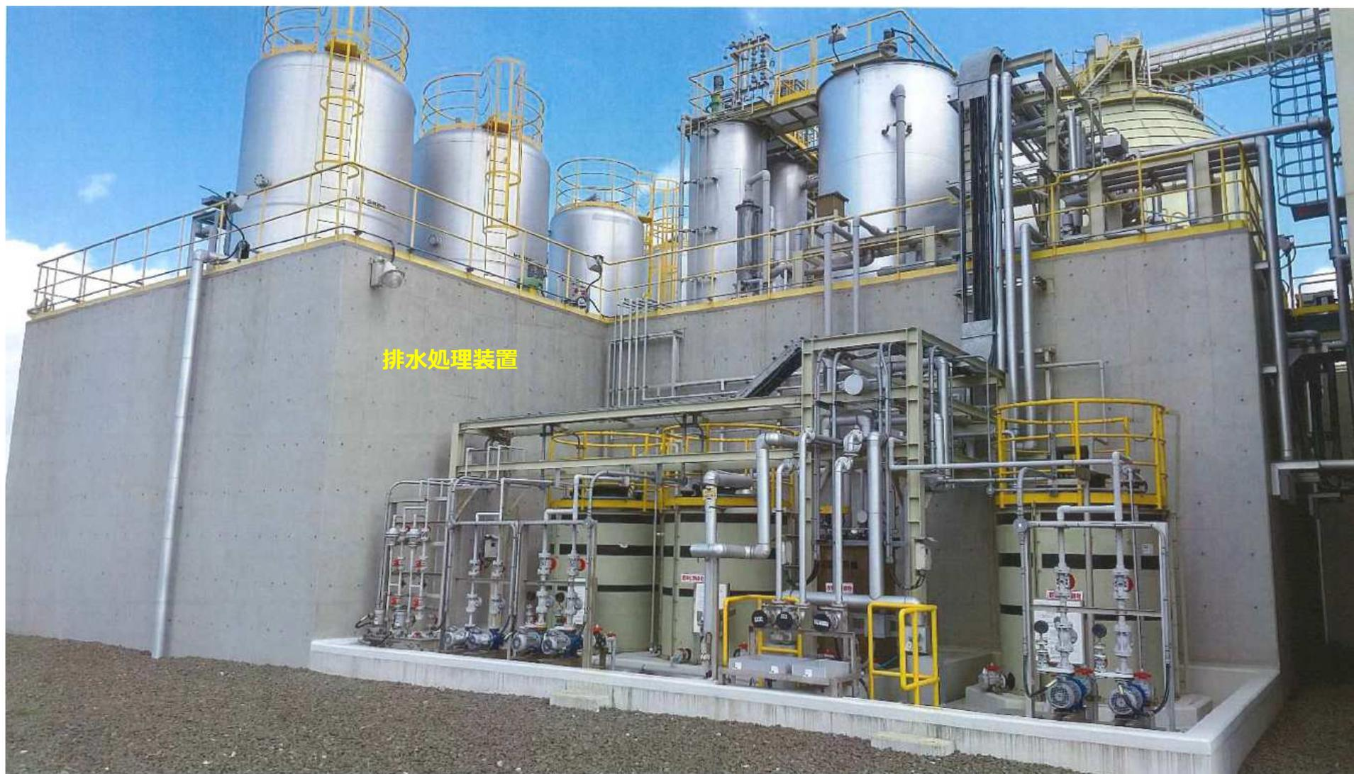
発電所稼働に伴い発生する排水は、この排水処理装置で、凝集沈殿、ろ過、中和等の処理を行い、浄化した上で放流しています。設備容量は1,920m<sup>3</sup>/日です。
