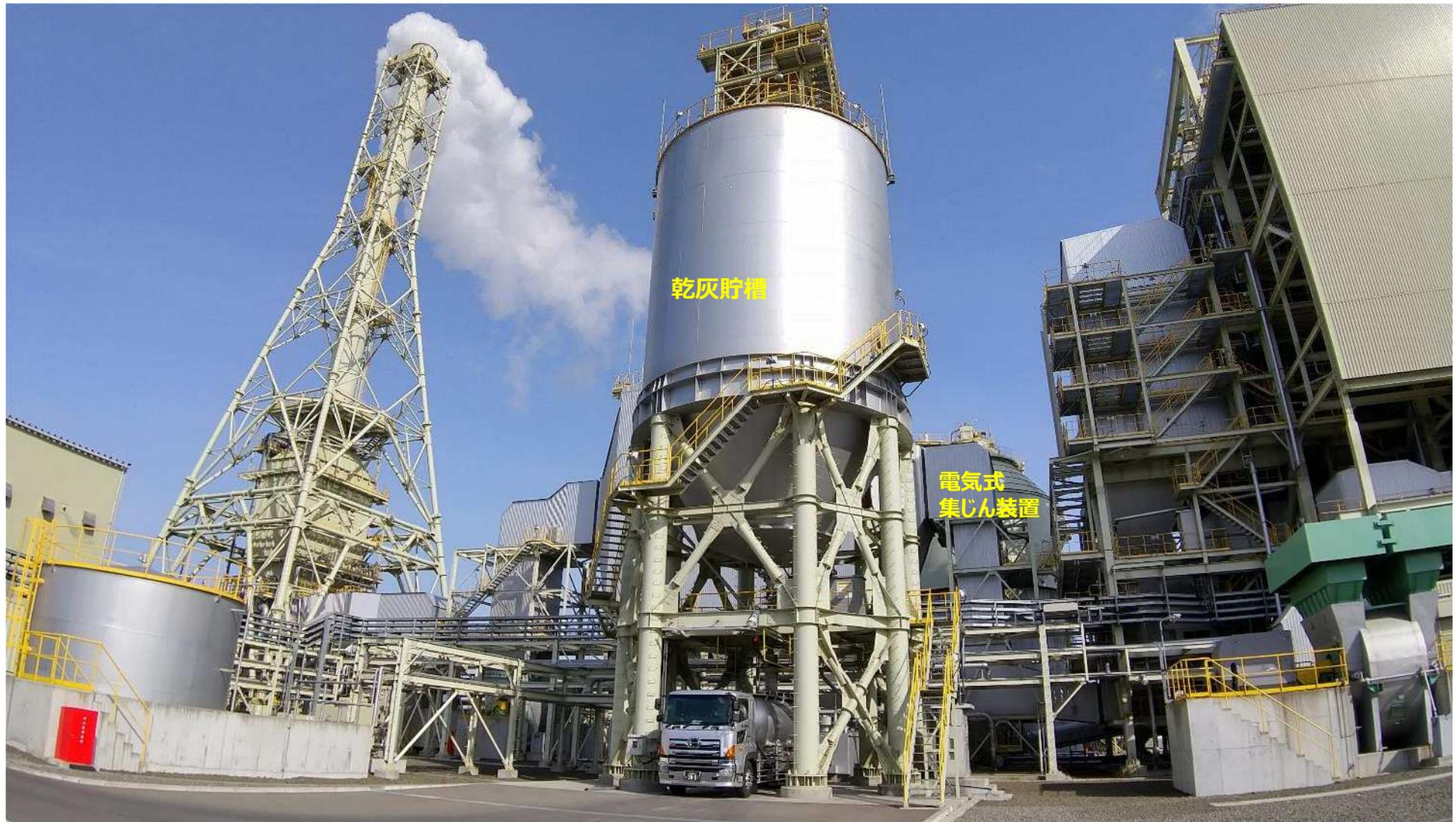
ボイラで石炭燃焼後に発生した石炭灰の内、電気式集じん装置で回収されたばいじんを貯槽する乾灰貯槽です。乾灰はセメント原料や建材原料（外壁材）としてセメント会社等へ全量リサイクルしています。
