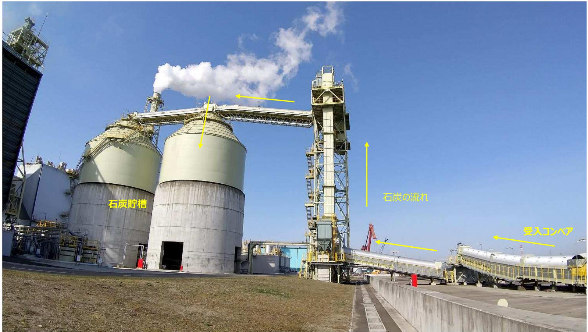
揚炭機で陸揚げされた石炭は、受入コンベアにより石炭貯槽まで運ばれます。石炭の運搬にあたっては、運搬・貯槽設備を密閉構造等にする
